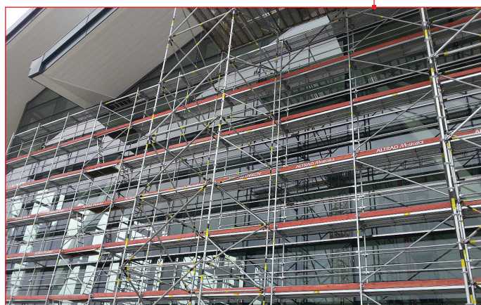
Prace przy fasadzie budynku lotniska
