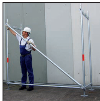
Zapiąć stężenie ukośne
