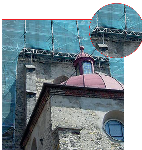
Renowacja fasady kościoła - Szydłowiec
