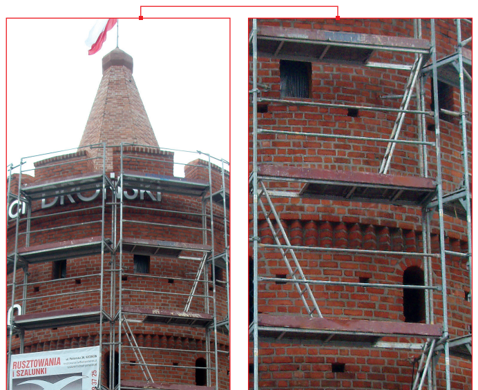
Renowacja fasady Baszty - Szczecin
