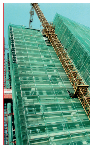
Budowa Apollo Rida - Warszawa
